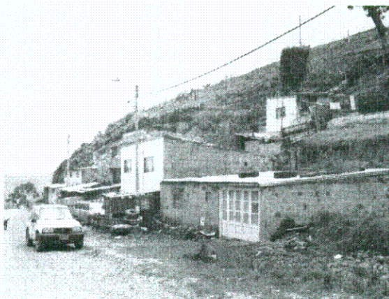
FOTOGRAFIA 1. VIVIENDAS LOCALIZADAS PARTE BAJA DE UNA LADERA DE PENDIENTE CASI VERTICAL.
