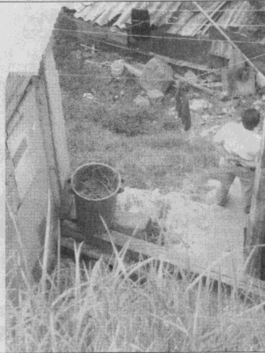
Fotografía 2 Obsérvese el sendero peatonal y el bloque en la parte baja sobre la vivienda de la Señora Pachón
