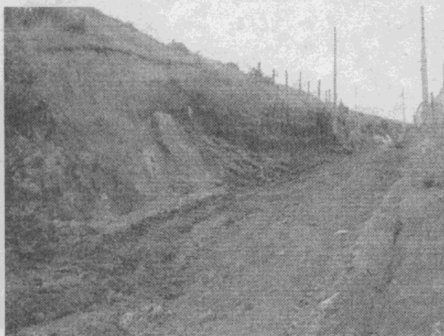
Fotografía 1: Panorámica del extremo oriental de la vía en construcción; obsérvese los taludes conformados a raíz de las excavaciones realizadas, el 26 de Abril de 2005.
