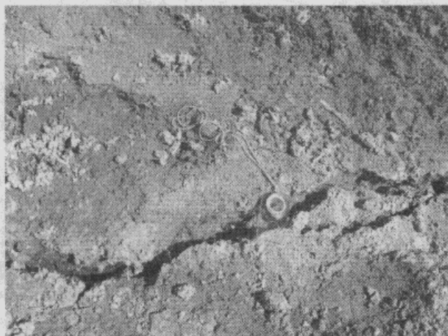
Fotografía 5: Grietas en la parte superior del deslizamiento.
