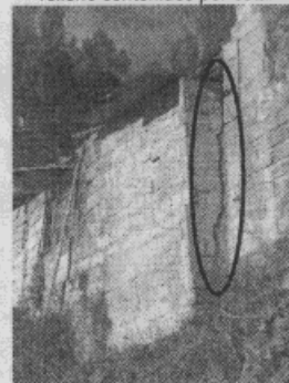
Foto 4. Detalle del recuadro de la Foto 3.
