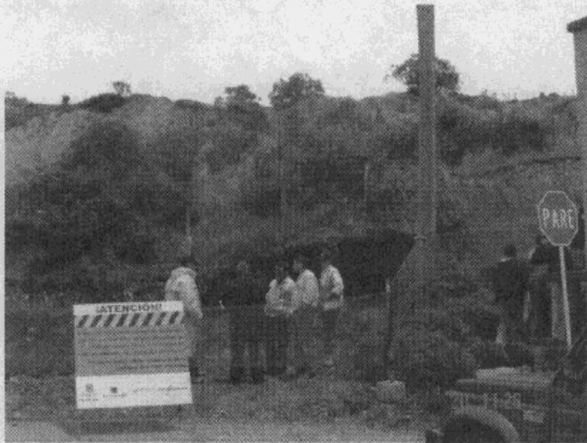
Fotografía 5: Panorámica del costado norte de la vía, nótese la ausencia de viviendas ladera arriba de ésta.
