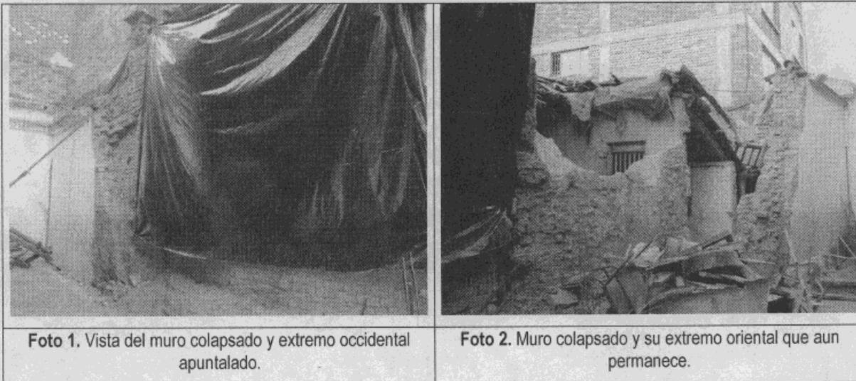
Foto 1. Vista del muro colapsado y extremo occidental apuntalado.
