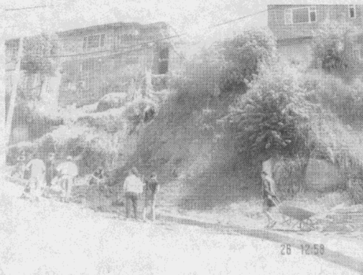
Caida de material sobre la calzada
