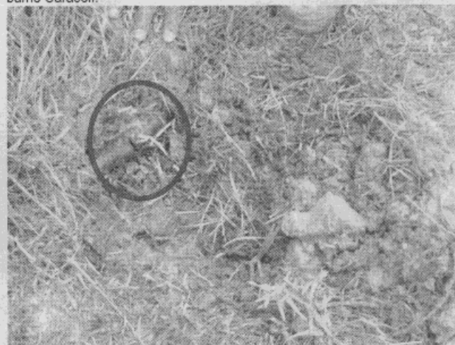
Foto 4. Corte transversal de la manguera, cerca del cerramiento, en el costado sur del Colegio Sierra Morena sede B. Este daño pudo representar un aporte importante de agua, definitivo para la generación del deslizamiento.
