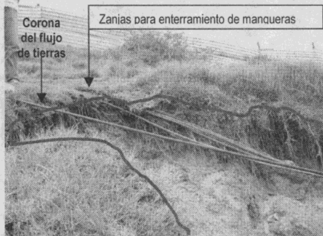
Foto 3. Mangueras distribuidas sobre la ladera en la corona del flujo de tierras, las mangueras están enterradas en zanjas que canalizaron el agua hacia el sitio del deslizamiento.
