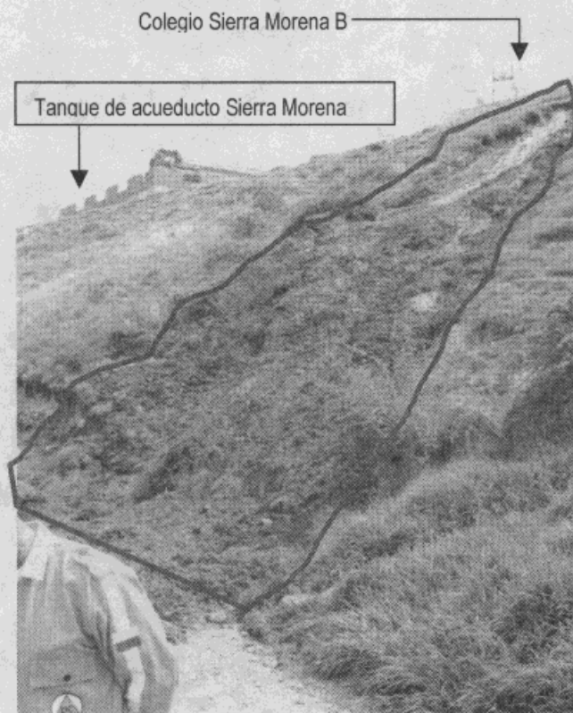
Foto 1. Flujo de tierras de suelo orgánico saturado y bloques de arenisca, al fondo se distinguen las instalaciones del colegio Sierra Morena Sede B (derecha), y los tanques de agua de Sierra morena (izquierda).
