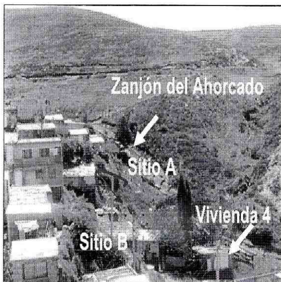
Fotografía 1 Panorámica de los deslizamientos
