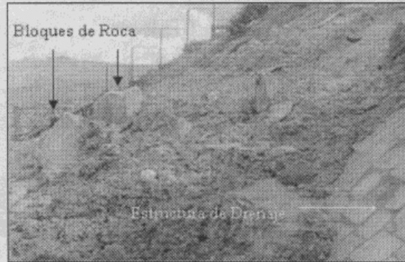
Fotografía 5 Pata del movimiento y protección del talud
