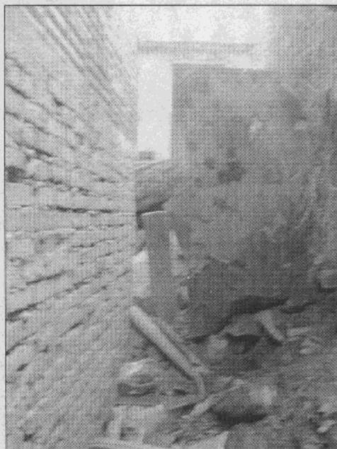
Fotografía 1 Vista de la zona de aislamiento
