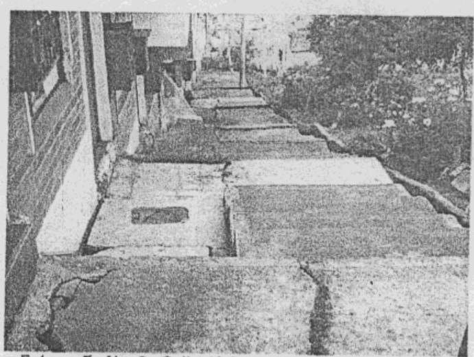
Fotografía No. 8. Calle 42 Sur, vista hacia el occidente
