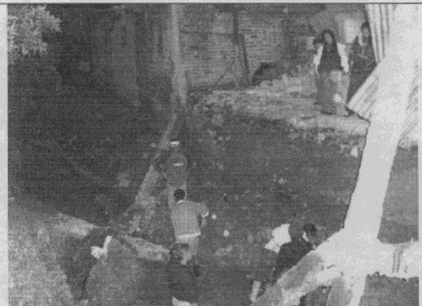
Fotografía 3. Colapso de la estructura y muro de cerramiento del taller en la Q. Trompéticas.
