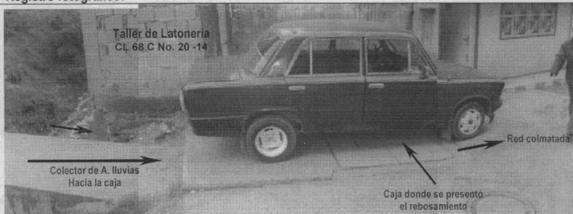
Fotografía 1. Localización de la caja de aguas lluvias colmatada que ocasionó el rebosamiento de las aguas que saturaron la cimentación del predio ubicado en Calle 68 C No. 20 -14 Sur (Taller de Latonería y Pintura) propiedad de Samuel Cordero.
