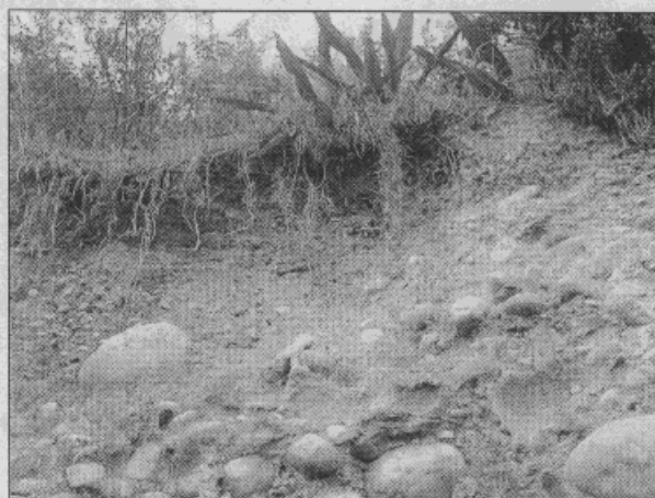
Fotografía 5 Vista del sitio del desprendimiento
