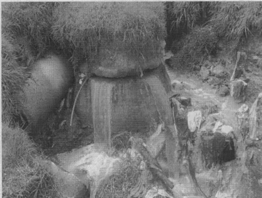
Foto 2: Cauce de la quebrada la Estrella obstruido por basuras
