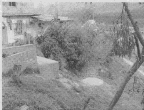
Fotografía 3 Área intervenida con redes de alcantarillado
