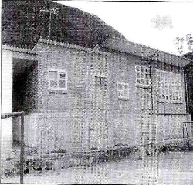
Fotografía 19. Vista de la parte posterior de la escuela, se observa el muro que contiene el relleno de nivelación y cimentación de la construcción.
