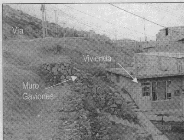
Fotografía 1. Panorámica del sector, tomada desde el extremo oriental.
