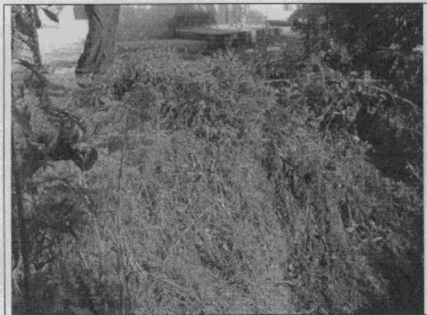
Fotografía 1. Vista del escarpe del deslizamiento (hacia el suroriente)
