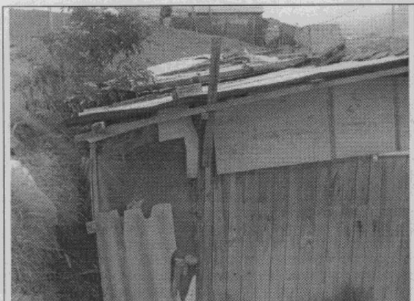
Fotografía 1. Vista lateral de la vivienda y corte realizado
