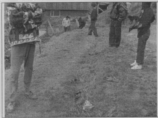
Fotografía 3. Grieta de tracción
