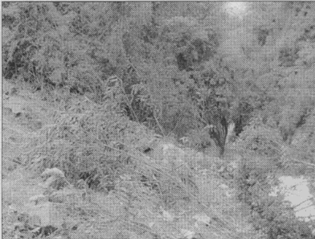
Fotografía 5. Se observa el cañón del río, aguas abajo del sitio del taponamiento.
