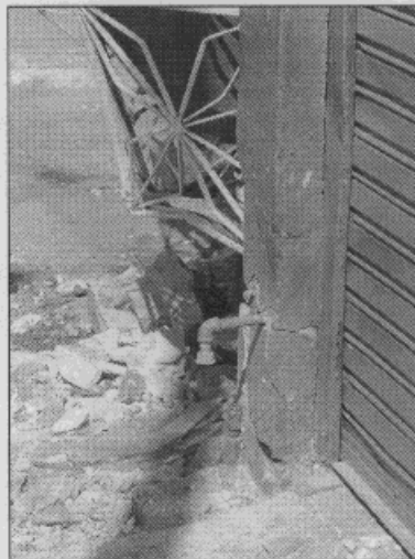
Fotografía 5 Desconexión servicio domiciliario de gas natural
