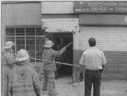
Fotografía 8 Retiro materiales inestables y escombros
