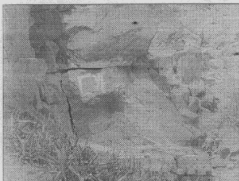
Fotografía 2 Orientación desfavorable del diaclasamiento
