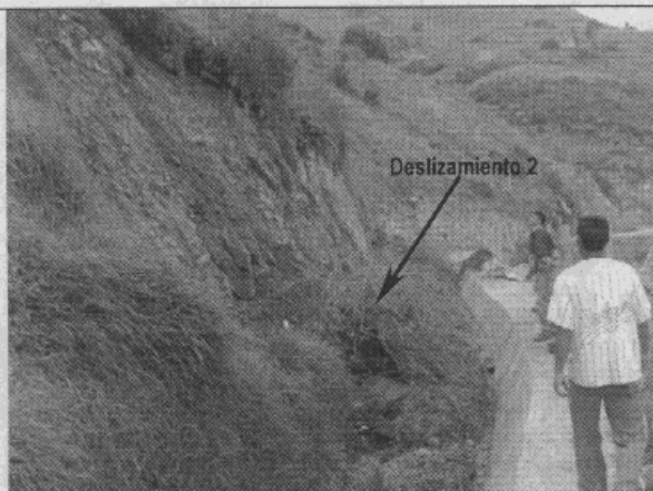
Fotografía 6. Talud de corte del canal y sector del Represamiento 2. (Véase Figura 1).
