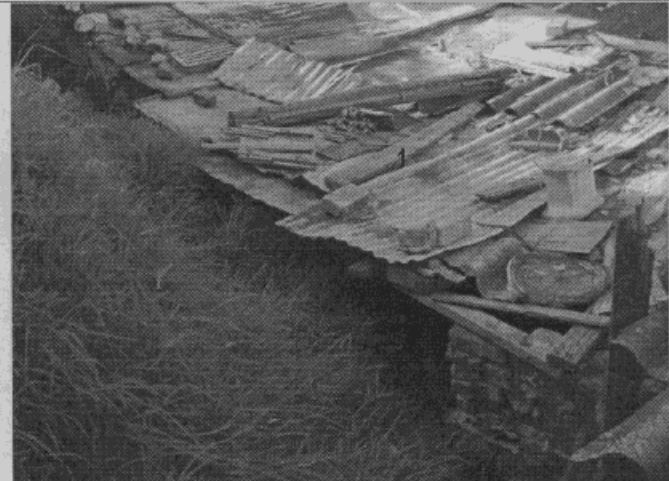
Foto 4. Se observa una vista de perfil del depósito producto del deslizamiento que provocó el colapso del muro de la parte posterior de la vivienda del Señor Melo (1).
