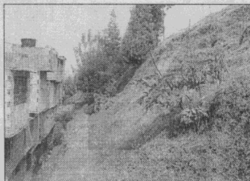
Fotografía 2 Después del deslizamiento
