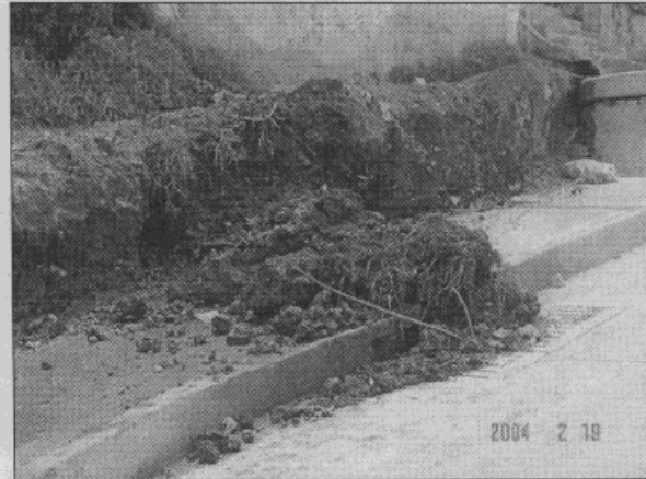
Foto 10. Materiales que obstruyen el sistema de alcantarillado.
