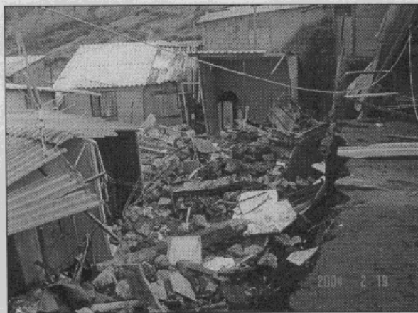
Foto 3. Vista de la zona donde colapsó el muro de contención.
