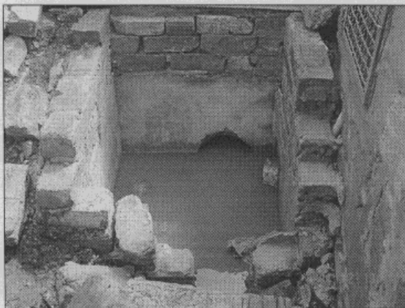
Foto 1. Caja de inspección de la vivienda de la Carrera 7A No. 163A - 31.
