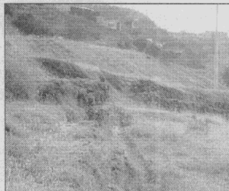
Fotografía 4 Terrazas y obras de drenaje superficial
