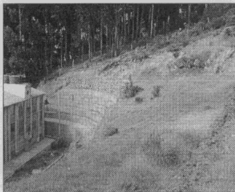
Fotografía 3 Talud confinado con muro en gaviones
