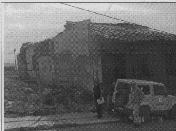
Foto 1. Vista general vivienda inspeccionada. Se observa el muro de lindero del costado oriental.
