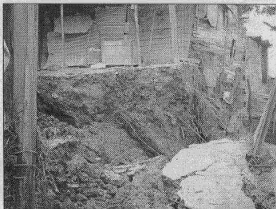
Fotografía 1 Deslizamiento en cuña en el Sector 1
