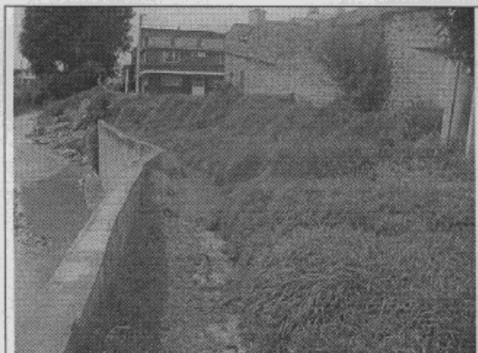
Foto 1. Vista general del muro
