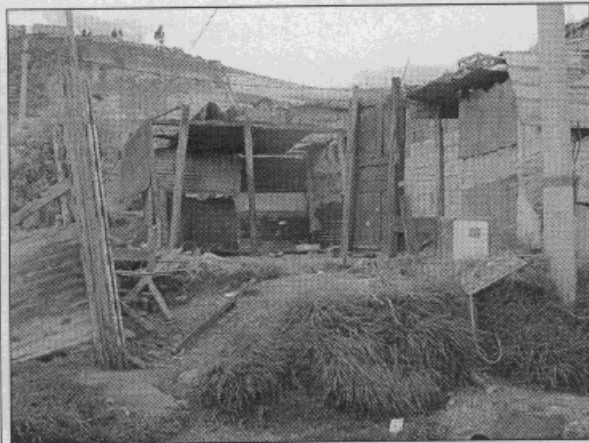
Foto No.1. Vista del predio y de los restos de la construcción.
