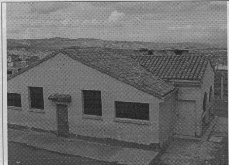
Foto 2. Vista hacia el interior del IED Jorge Soto del Corral. Edificación aislada cuya construcción tiene más de 40 años de acuerdo a sus características. No se observaron daños.
