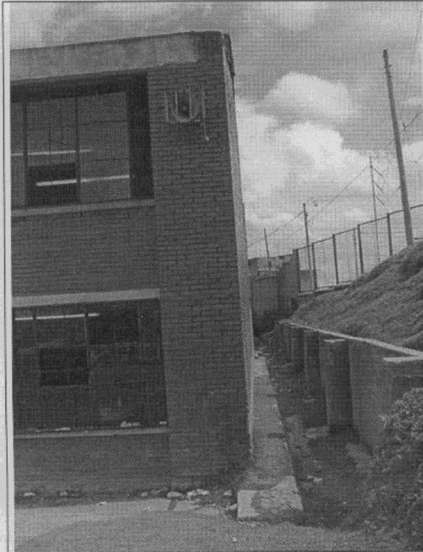
Foto 3. Muro de contención construido hace aproximadamente un año, ubicado sobre el costado oriental de la institución.
