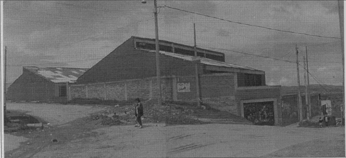
Foto 1. Vista general IED Jorge Soto del Corral, costado oriental. La planta física está localizada sobre una ladera de mediana pendiente.
