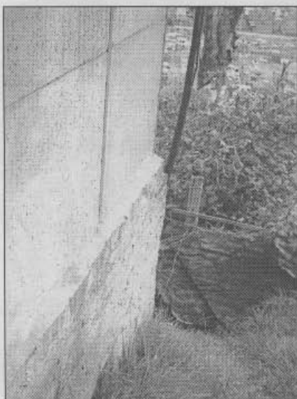
Fotografía 7 Contención en mampostería
