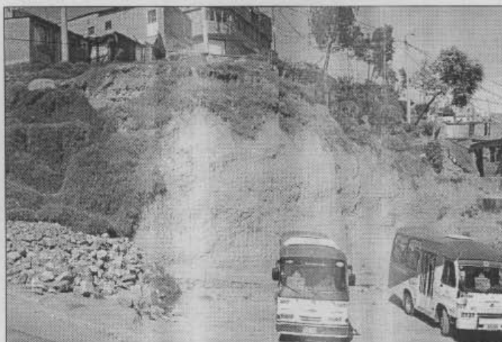
Fotografía 1 Vista general del talud
