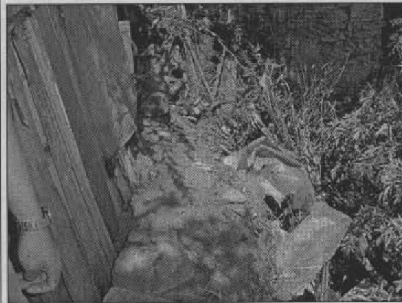
Foto No.3. Vista del escarpe generado por el deslizamiento, a la izquierda se observa la cercanía de un rancho en material de recuperación al escarpe.
