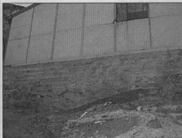
Foto No.11. Vista del extremo occidental de la vivienda prefabricada; obsérvese la condición del muro de contención que soporta el relleno .
