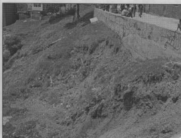
Foto No.2. Vista del deslizamiento ocurrido en mayo del año anterior; tomada el 17 de marzo del presente año.
