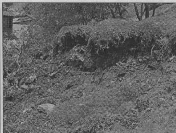
Foto No.4. Se observa el tipo y composición de material deslizado: relleno, basuras, escombros, etc.
