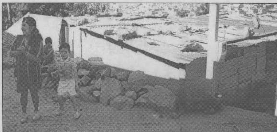
Fotografía 3 Vivienda ubicada bajo el nivel de la vía (Ítem 2)
