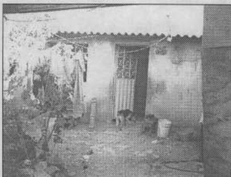
Fotografía 6 Vista general de la vivienda (Ítem 4)
