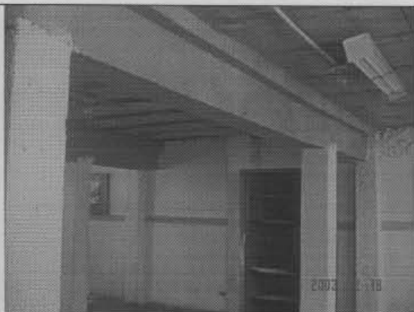
Foto 11. En el interior del Bloque B2, se construyeron pórticos en concreto reforzado en el primer piso. La placa de entrepiso es aligerada con bloque de arcilla.
