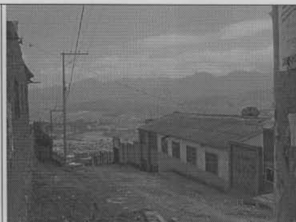
Foto 3. Fachada lateral. La construcción con teja corresponde al Bloque B2.
