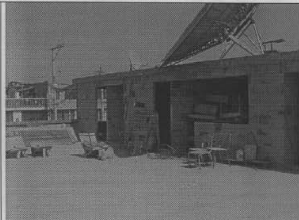
Foto 2. Segundo piso Salón Comunal Isla del Sol; su sistema estructural es de mampostería no reforzada.
