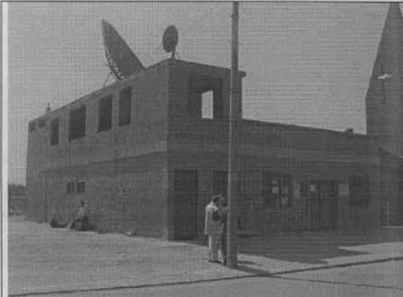
Foto 1. Vista general Salón Comunal Isla del Sol (calle 67 B sur No. 62-07). El segundo piso corresponde a una ampliación en la que no se tomó en cuenta parámetros de sismo resistencia.
