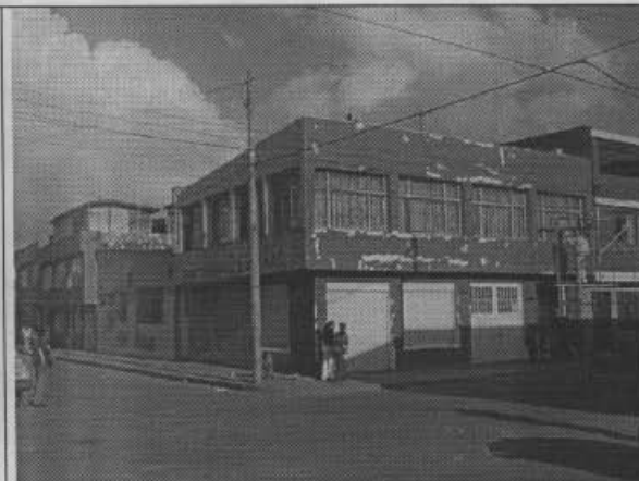
Foto 16. Vista general Salón Comunal Barrio Fátima (calle 51 sur No. 37-98).
