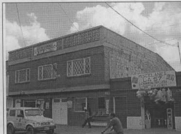
Foto 19. Vista general Salón Comunal San Benito (calle 57 sur No. 18 A-19). Hacia el interior en la zona de dos pisos se observaron columnas de concreto reforzado; lateralmente en la fachada se ve un sistema estructural de mampostería no reforzada.
