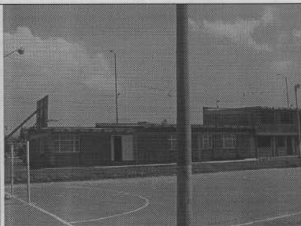
Foto 8. Vista general Salón Comunal Tejar de Ontario (Av. Boyacá No. 27-75 sur). En la emergencia de la inundación del río Tunjuelo, la lámina de agua cubrió 0.70 metros la cancha.
