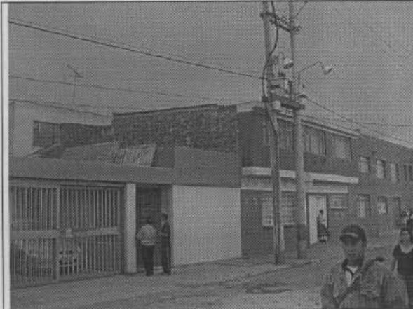
Foto 21. Vista general Salón Comunal El Carmen (calle 48 B sur No. 28-70). El sistema estructural es de mampostería no reforzada.
