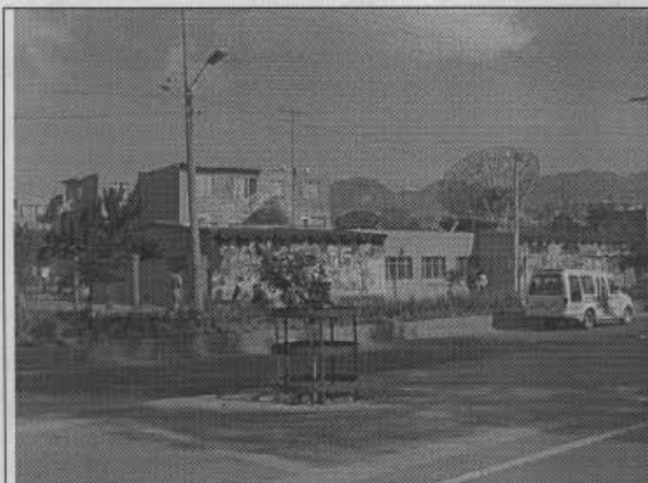
Foto 13. Vista general Salón Comunal Ciudad Tunal I (calle 48 B sur No. 21-50). Se ha presentado vandalismo cuando se realizan eventos masivos en el parque el Tunal.
