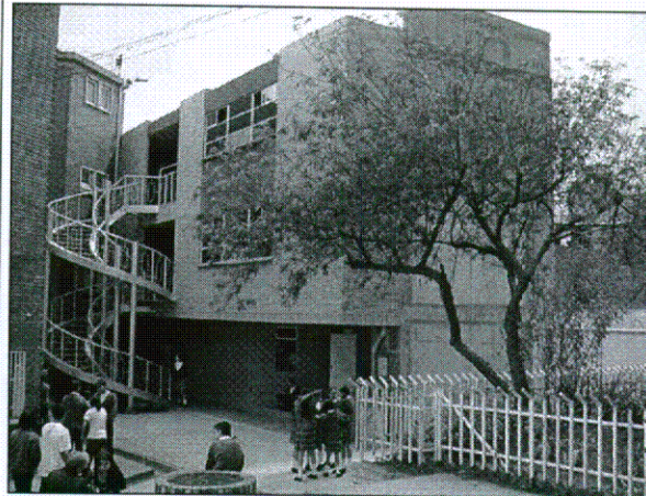
Foto No. 2. Vista del edificio de laboratorios.
