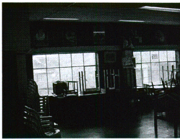
Foto No. 10. Vista del costado norte en el segundo piso del edificio donde funciona la biblioteca.
