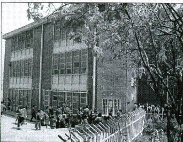
Foto No. 3. Vista del edificio de salones de clase.
