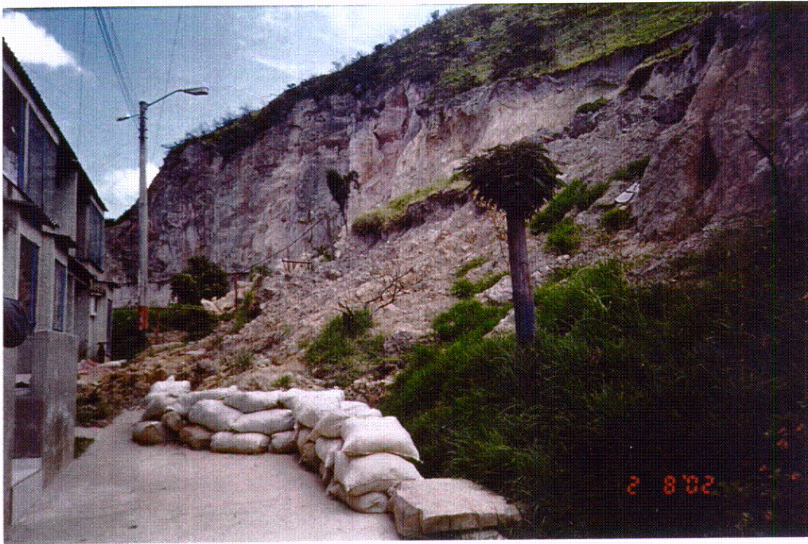
1. Deslizamiento en la Urbanización Providencia; invasión del andén y amenaza a las viviendas.
