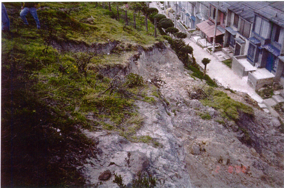
2. Corona del deslizamiento.
