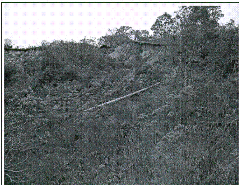
FOTOGRAFIA 6. Finca El Volcán. Parte superior de la finca. Escarpe de falla.
