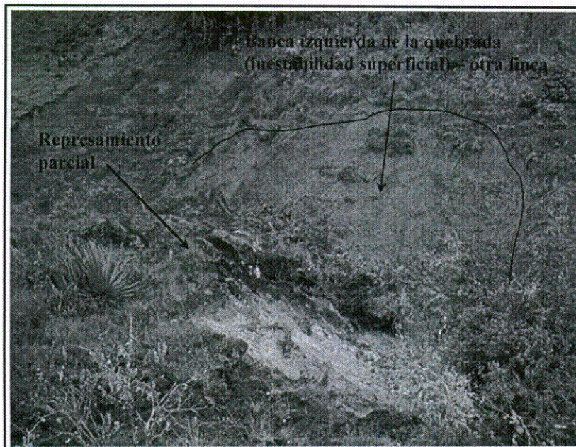
FOTOGRAFIA 3. Zona de deslizamiento que represó la quebrada La Montañuela
