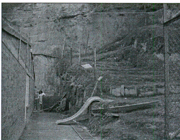
Foto No.6. Vista del talud vertical en el relleno de escombros de excavación; al costado sur del jardín.
