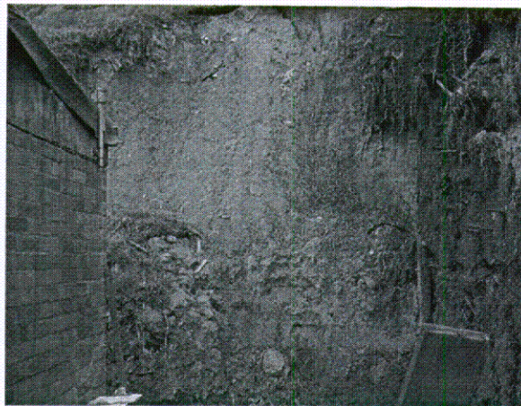
Foto No.4. Vista frontal del deslizamiento.
