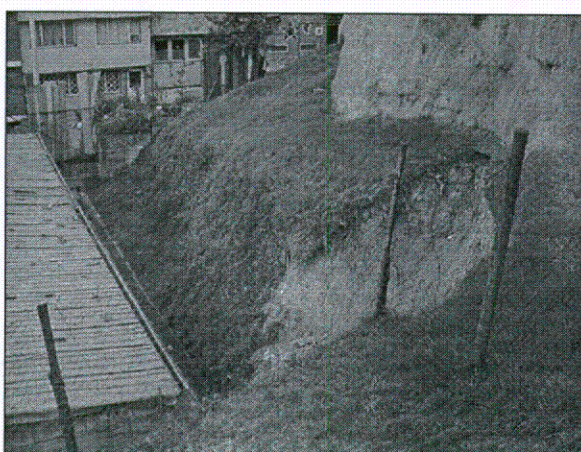
Foto No.2. Vista superior del escalón ubicado en la pata del talud rocoso recubierto.
