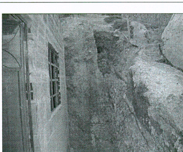
Foto No.5. Vista del talud ubicado sobre la calle 77 Sur. Obsérvese los materiales presentes.
