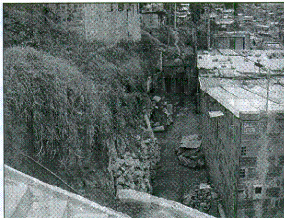
Foto No.2. Se observa el talud de la carrera 21.
