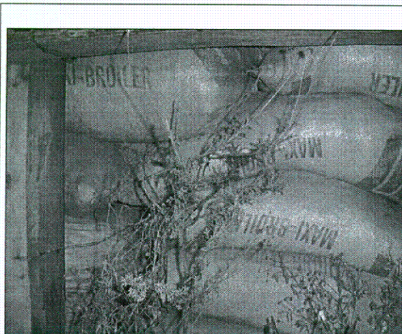
Foto No.1. Vista del sistema de protección del talud, conformado con lonas llenas con recho (bolsa-recebos).
