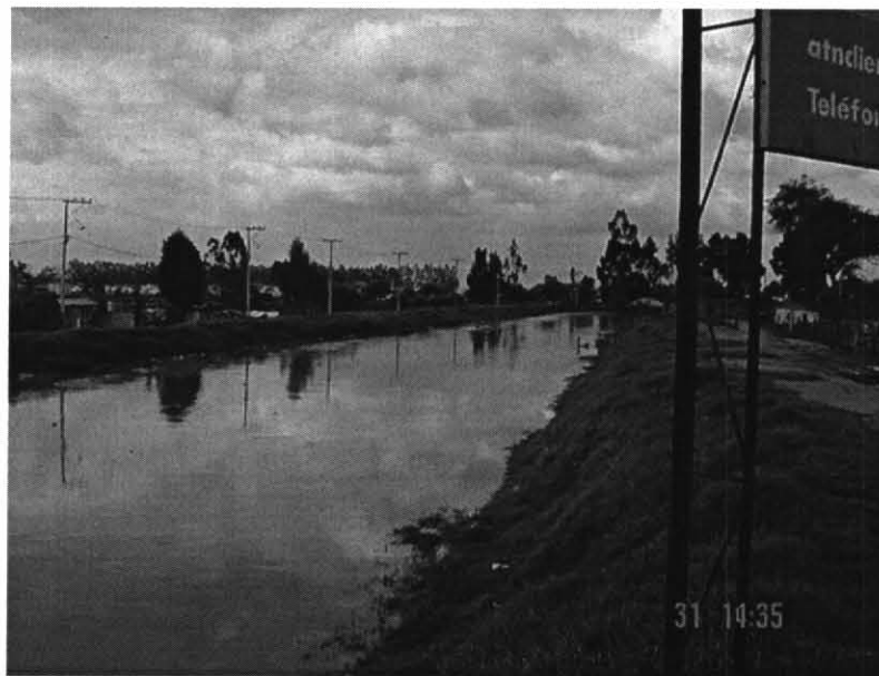
Foto 4. Vista hacia aguas abajo del río Tunjuelito en la zona del barrio Antonia Santos en la localidad de Bosa. Obsérvese el alto nivel de las aguas.
