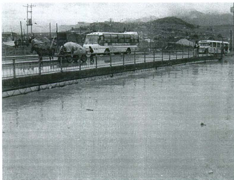
Foto 4. (Mayo 31 –2002, 11:33 AM). Costado aguas arriba del puente sobre el río Tunjuelo en el barrio Meissen. El nivel del agua ha ascendido 50 cm en 51 minutos.
