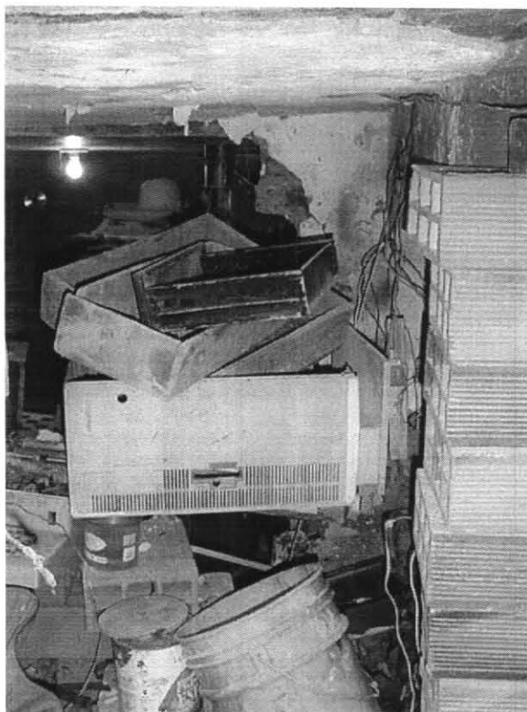
INTERIOR DE LA VIVIENDA EN EL QUE SE OBSERVA UN SECTOR DE MURO DIVISORIO QUE FUE DEMOLIDO
