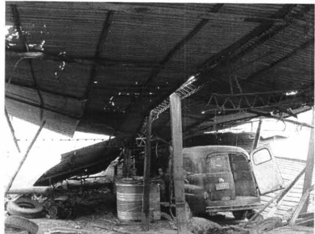
FACHADA Y COLAPSO DE LA ESTRUCTURA DE LA PARTE POSTERIOR DEL TALLER
