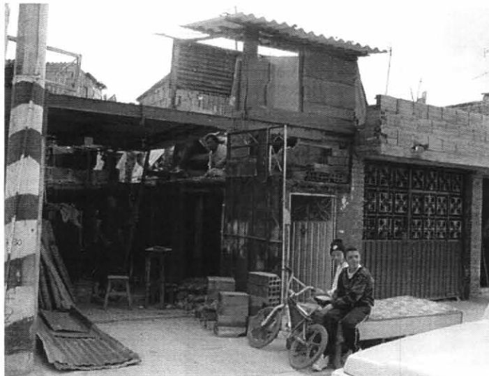
FACHADA DE VIVIENDA TRANSV. 13A # 59 – 35 SUR
