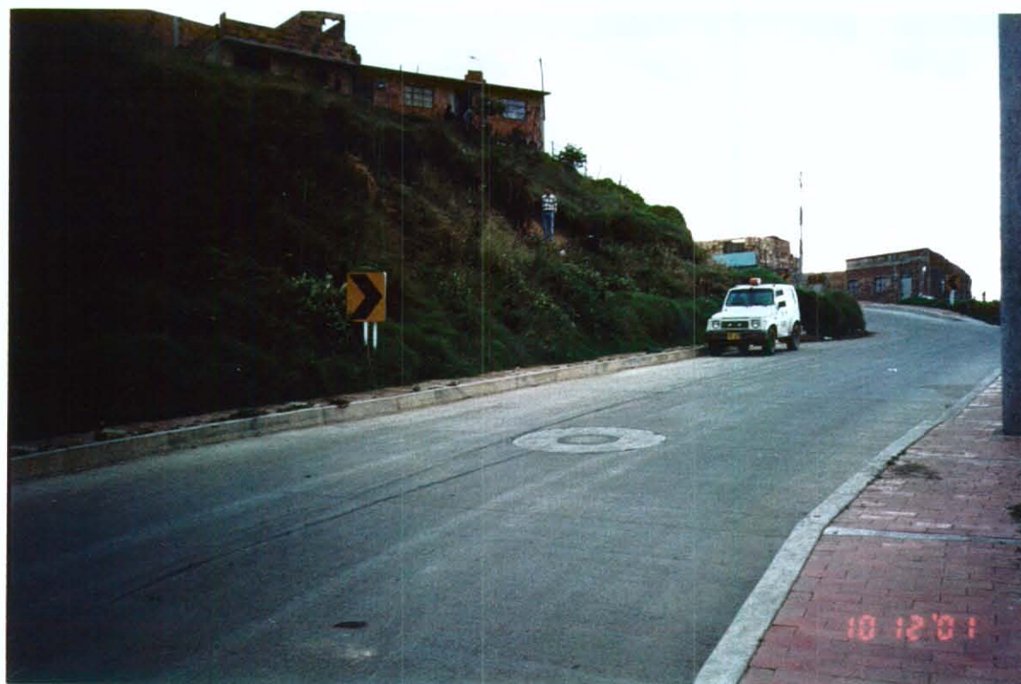
2. Vista desde el norte del deslizamiento.
