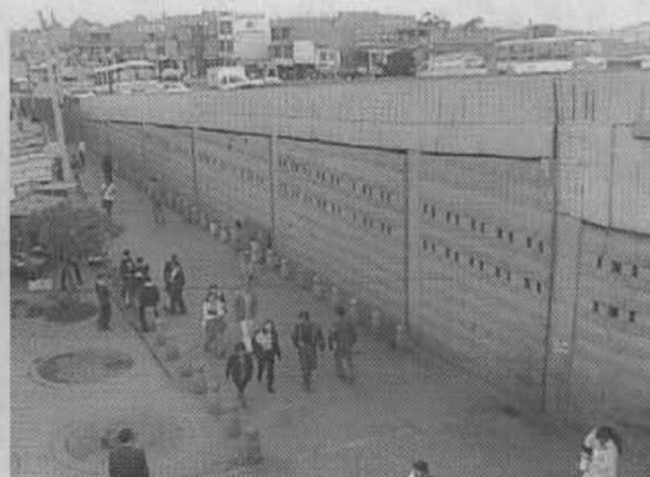
*Figura 4: Muros de mampostería en las rampas de acceso en diferentes sectores del viaducto*
